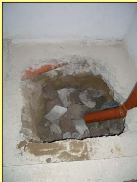
*ca. 1 x 1 m Schacht mit Entlüftungsrohr*
