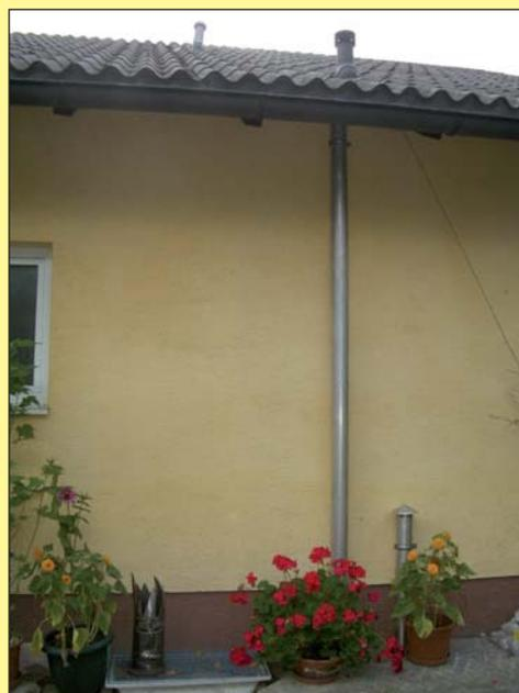
*Abluftrohr über Dach mit Ventilator*
