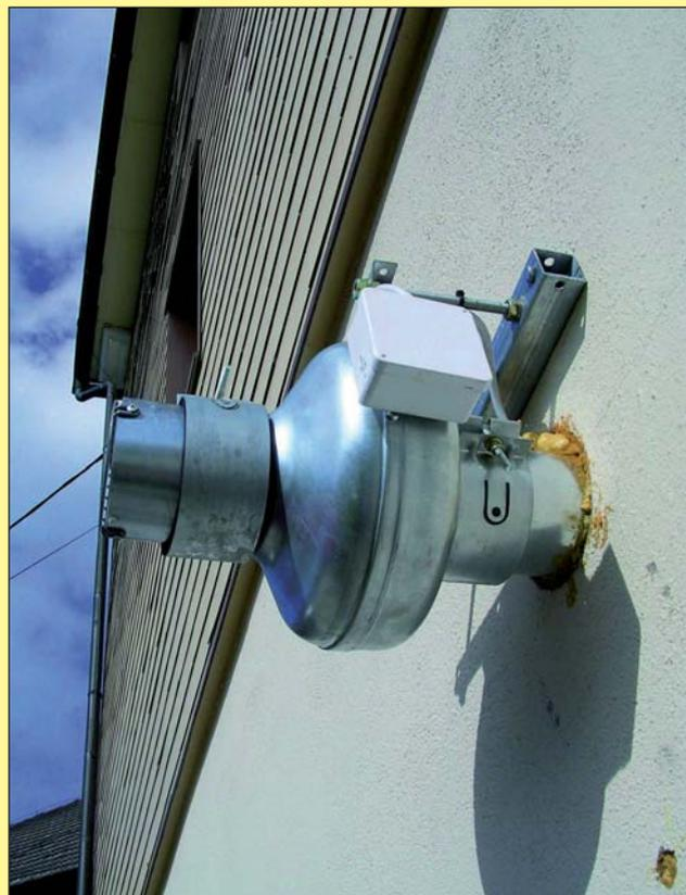
*Abluftventilator an der Außenmauer*
