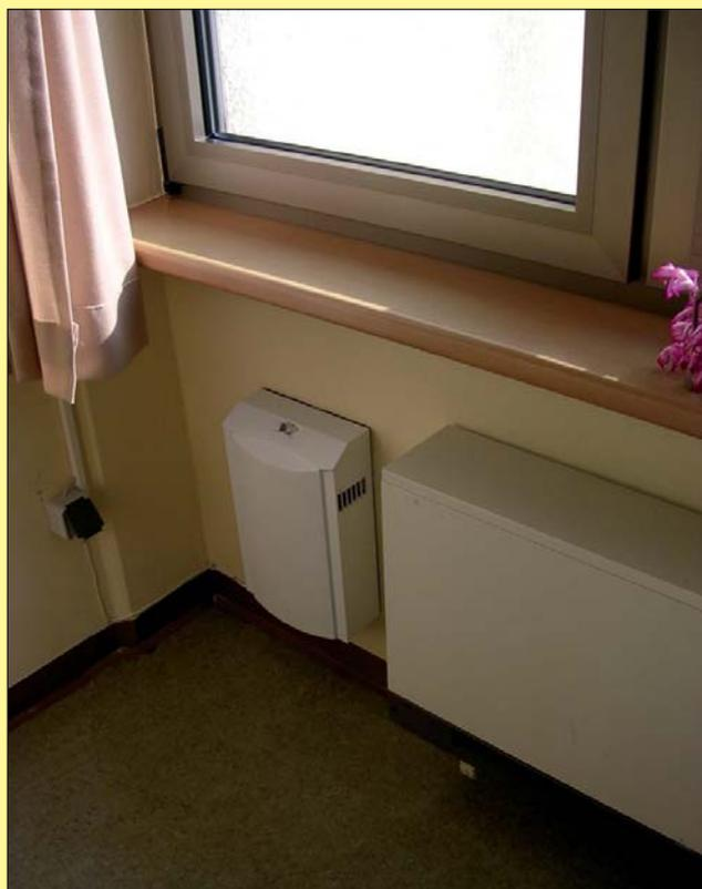
*Zuluftventilator unter dem Fenster*
