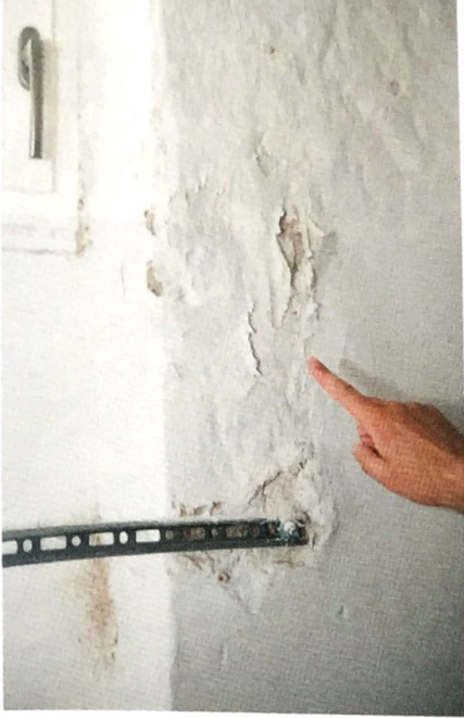
Putzabplatzungen können auf Feuchtigkeit in den Kellerwänden hinweisen. Das kann unter Umständen eine teure und aufwendige Sanierung der Mauern zur Folge haben. Isotec
