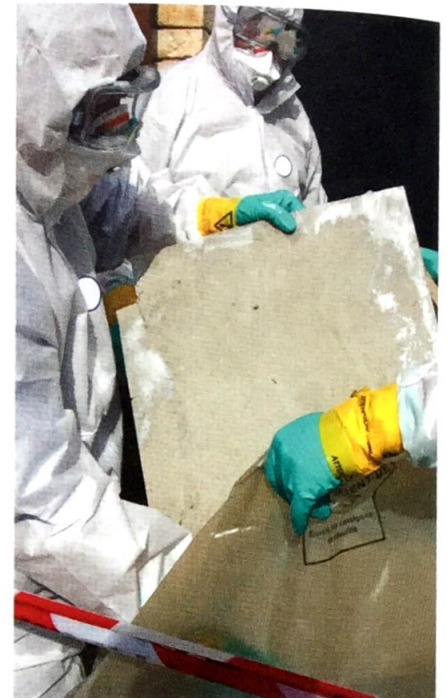
Die Identifikation belasteter Baustoffe ist das eine, der fachgerechte Ausbau und die Entsorgung sind aber genau so elementar und dürfen teilweise nur von spezialisierten Betrieben durchgeführt werden. thinkstock/bermau
