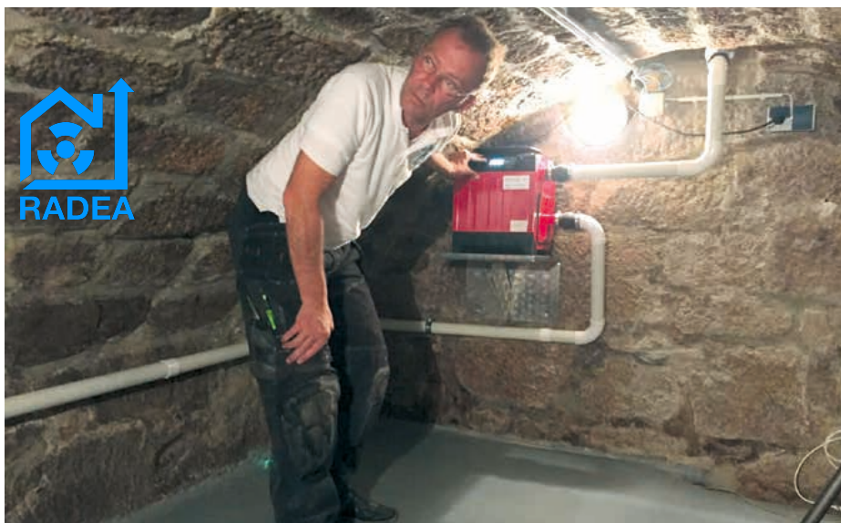
Dirk Jung bei einer Radon-Sanierung mit dem Radea-Absaugsystem.
